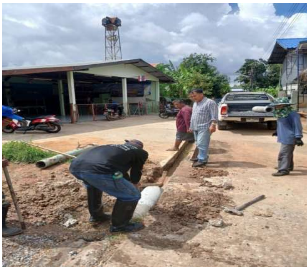
รูปภาพที่ 4.6 ประกอบการบริการงานด้านโยธา (การขออนุญาตปลูกสิ่งก่อสร้าง) อาทิ การบริการซ่อมแซมถนนในชุมชนและร่องระบายน้ำในชุมชน อบต.โนนแดง เป็นต้น
