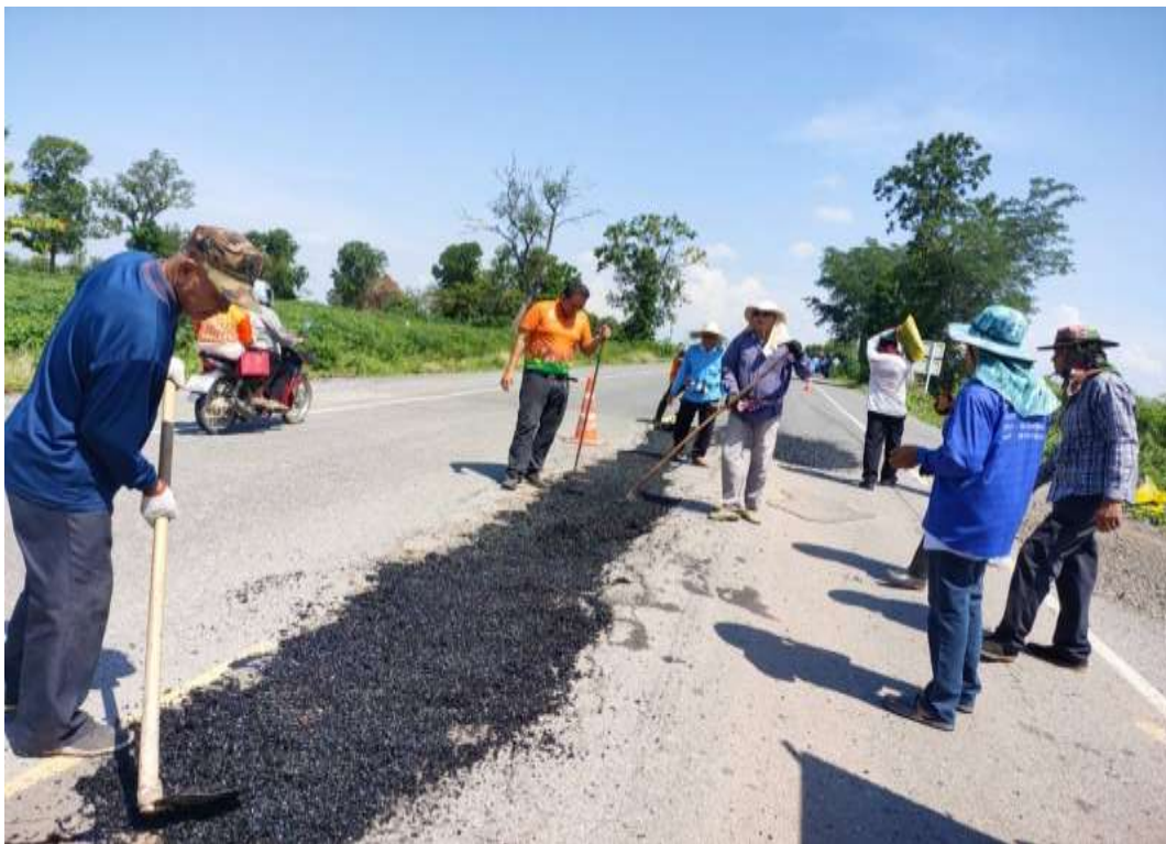
รูปภาพที่ 4.4 ตัวอย่างการบริการงานด้านโยธา (การขออนุญาตปลูกสิ่งก่อสร้าง) อาทิ การบริการซ่อมแซมถนนที่ชำรุด หรือเป็นหลุมเป็นบ่อ ให้มีสภาพการใช้งานได้อย่างสะดวกและปลอดภัย
