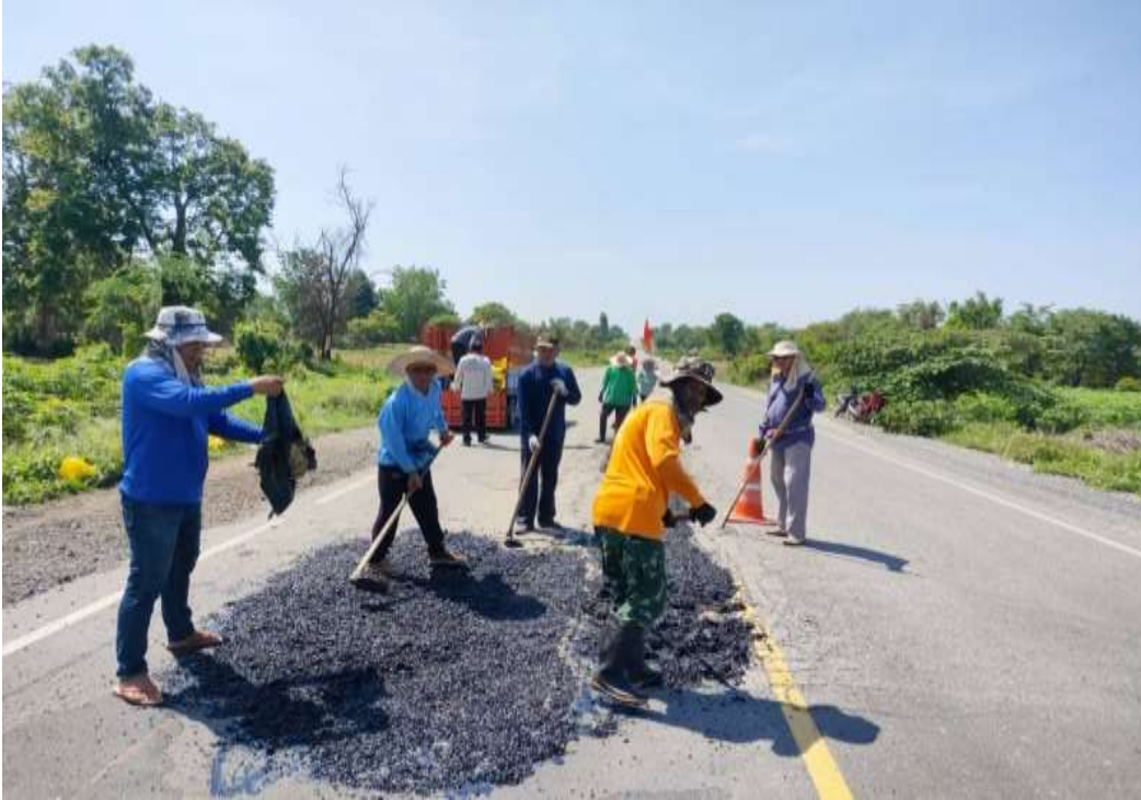
รูปภาพที่ 4.3 ตัวอย่างการบริการงานด้านโยธา (การขออนุญาตปลูกสิ่งก่อสร้าง) อาทิ การบริการซ่อมแซมถนนที่ชำรุด หรือเป็นหลุมเป็นบ่อ ให้มีสภาพการใช้งานได้อย่างสะดวกและปลอดภัย
